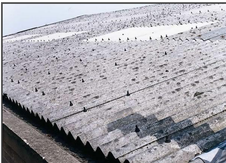
Rysunek 1. Dach pokryty azbestową płytą falistą
